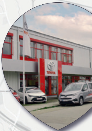
LECHHAUSEN Donaustraße 13 86165 Augsburg 0821/79081-0
